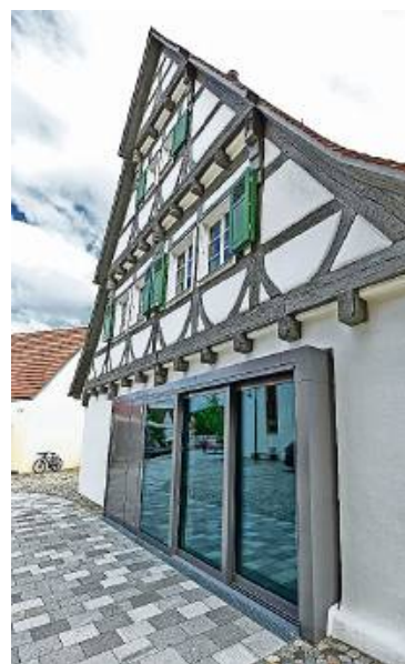
Der Fachwerkbau lässt sich zum Kirchplatz hin weit öffnen.
